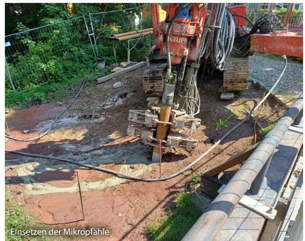
Bohrung für die Mikropfahlgründung
