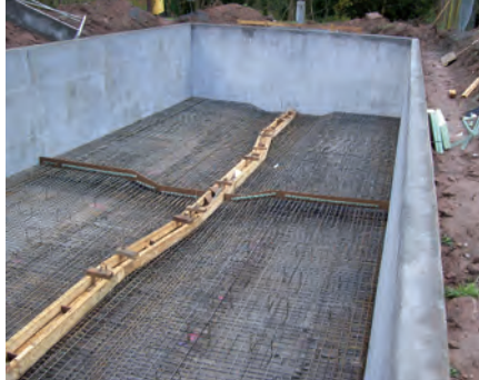
Das neue Rückhaltebecken kurz vor der Fertigstellung
